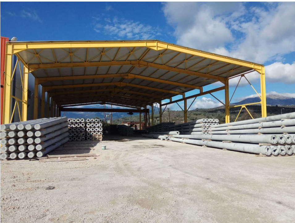
Φωτ. 4 Υπόστεγο αποθήκευσης κολονών
