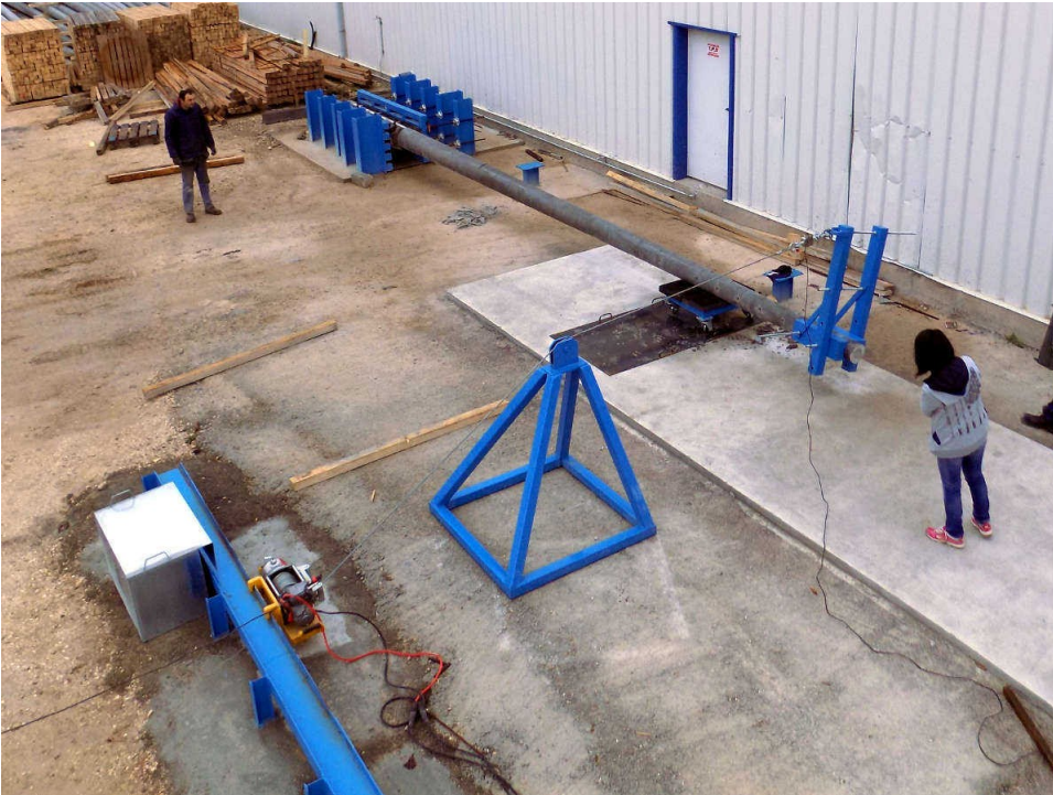
Φωτ 5. Δοκιμή στύλου σε κάμψη και στρέψη
